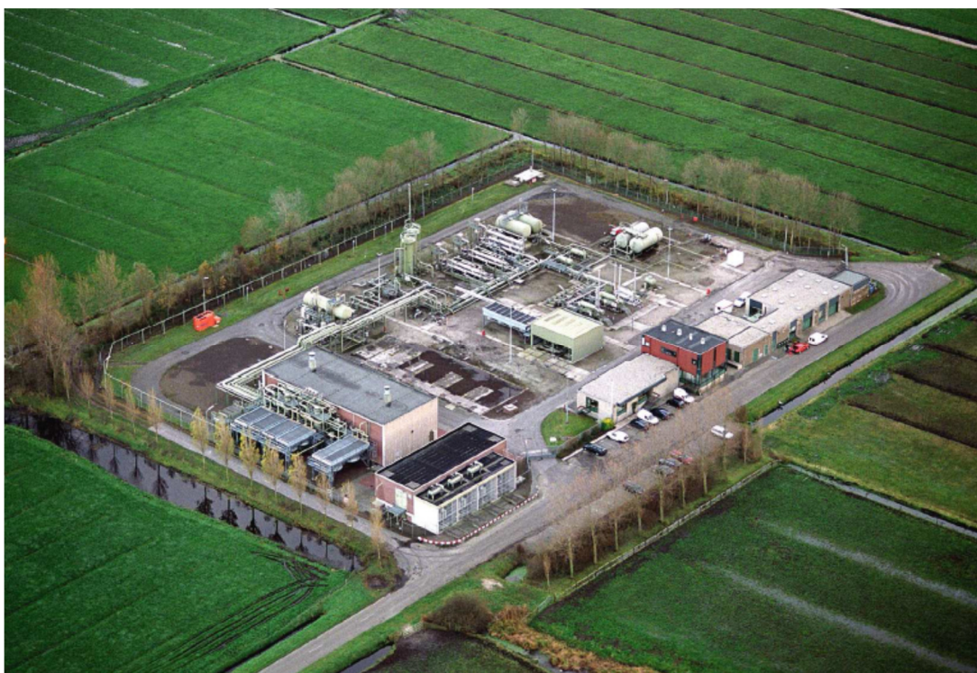
Figuur 2-6: Luchtfoto van het Garijp Gasbehandeling Station (GTC).
