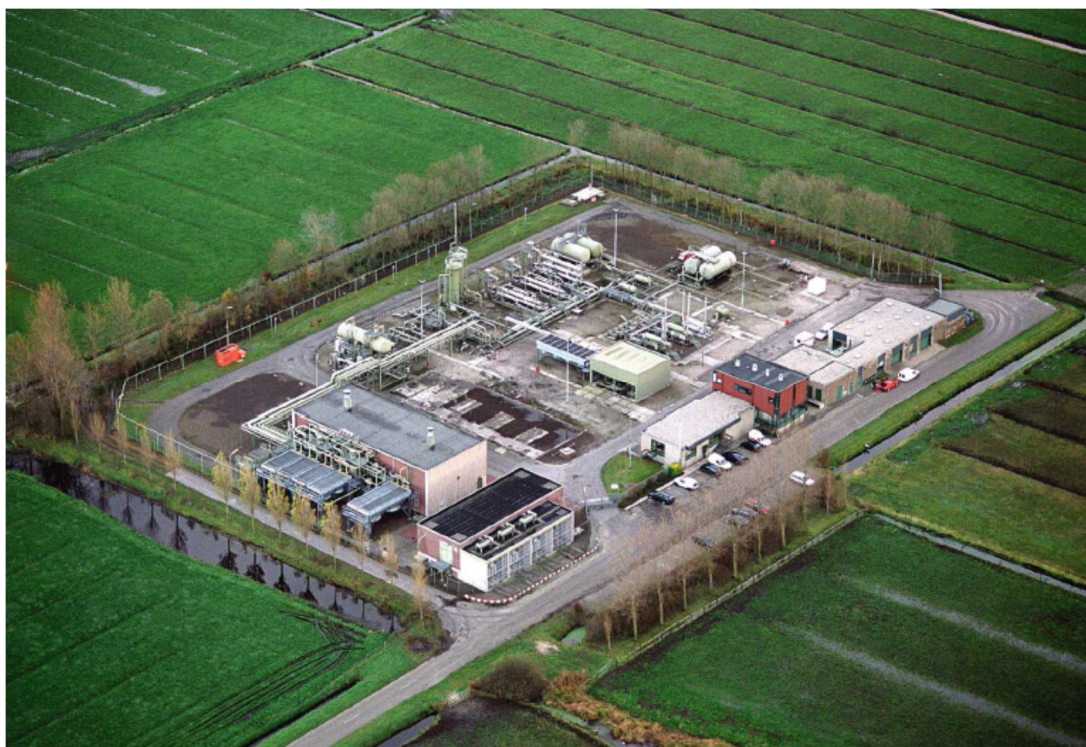
Figuur 2-4: Luchtfoto van het Garijp Gasbehandeling Station (GTC).
