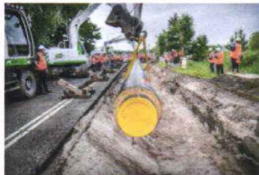
In juli 2017 was het officiële startmoment van de aanleg van het aardwarmtenet in Groningen. Foto: Corné Spardeens
