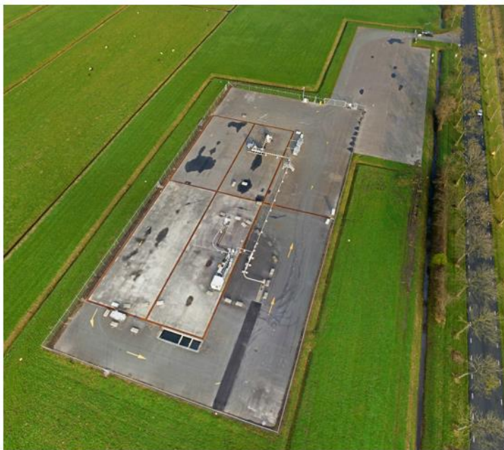
Figuur 3-2: Luchtfoto van de productielocatie.
