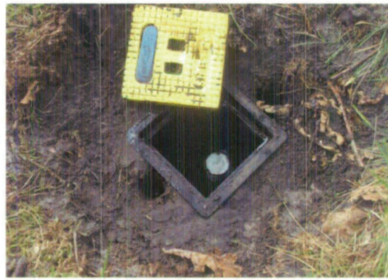
Afb. 5: schroefanker afgewerkt met putje
