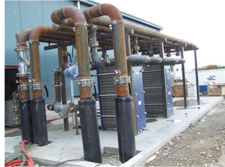
Voorbeeld van een aardwarmtewisselaar (bron: www.energieportal.nl )
