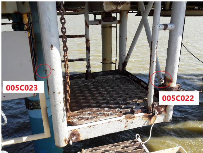
Figuur 2 Overzichtsfoto hoogtemerken 005C0022 en 005C0023 (onderzijde dek gasproductieplatform)
