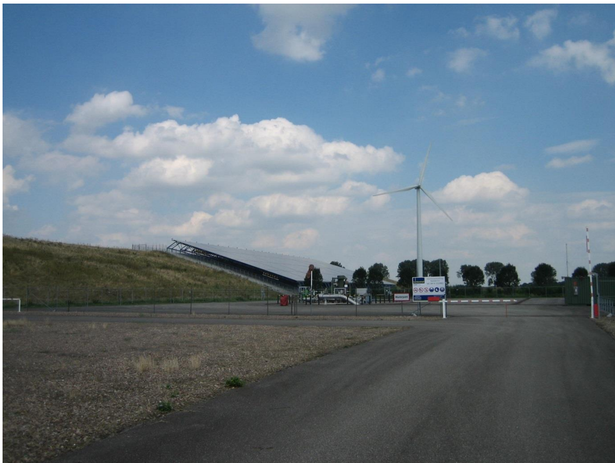
Figuur 11-6 Foto mijnbouwlocatie Waalwijk N3 (foto genomen vanaf de ingang).
