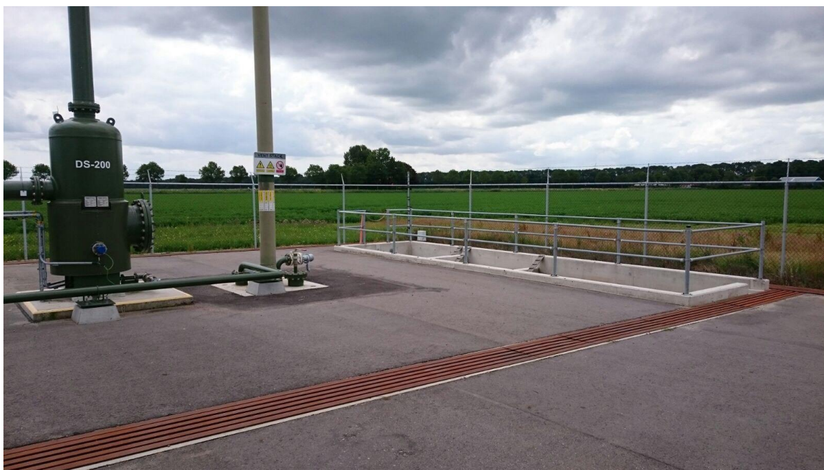
Figuur 13-12: Foto van de vent stack met vloeistof separator.
