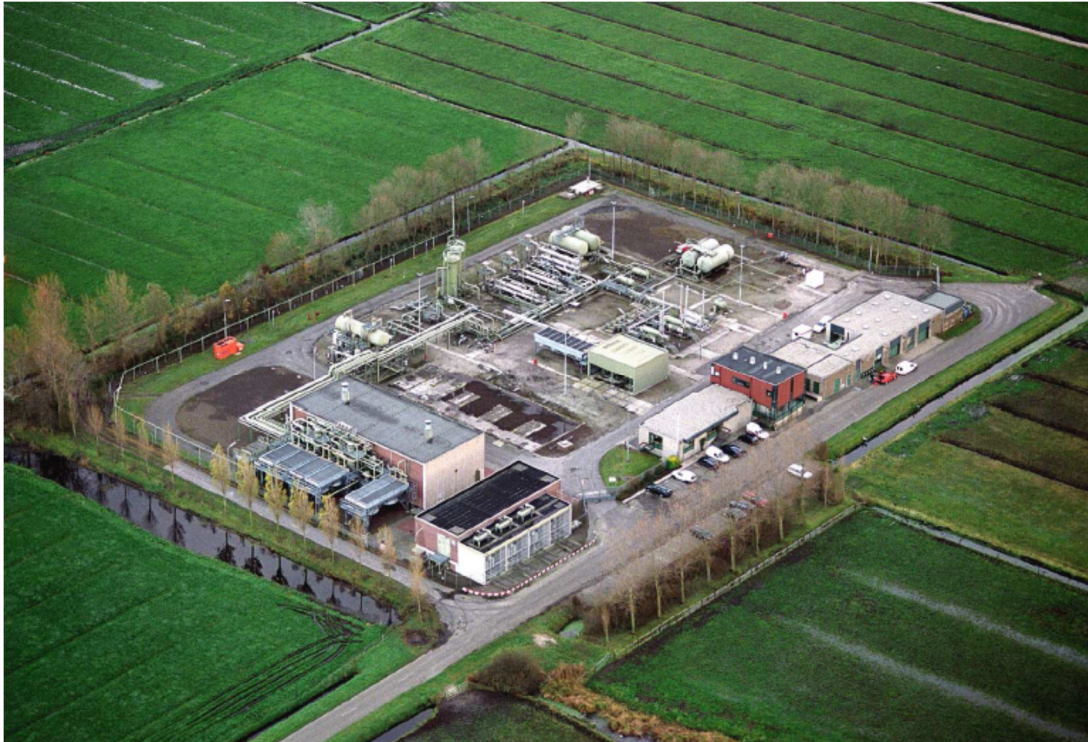
Figuur 2-4: Luchtfoto van het Garijp Gasbehandeling Station (GTC).
