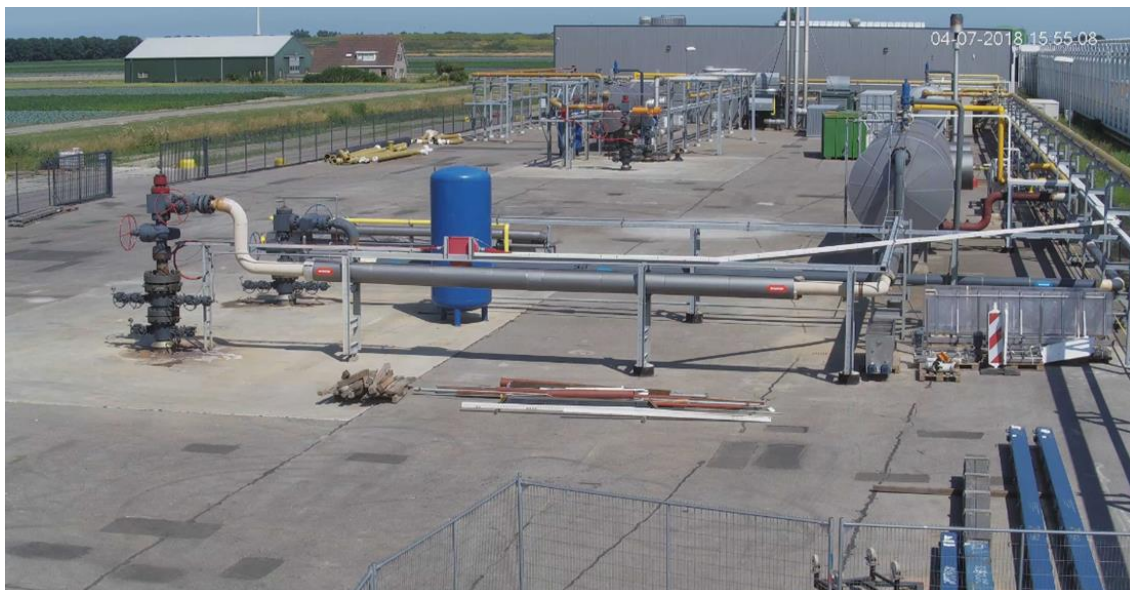
Figuur 6. Foto van het mijnbouwwerk AWI Oostlanderweg Middenmeer (buitenterrein)
