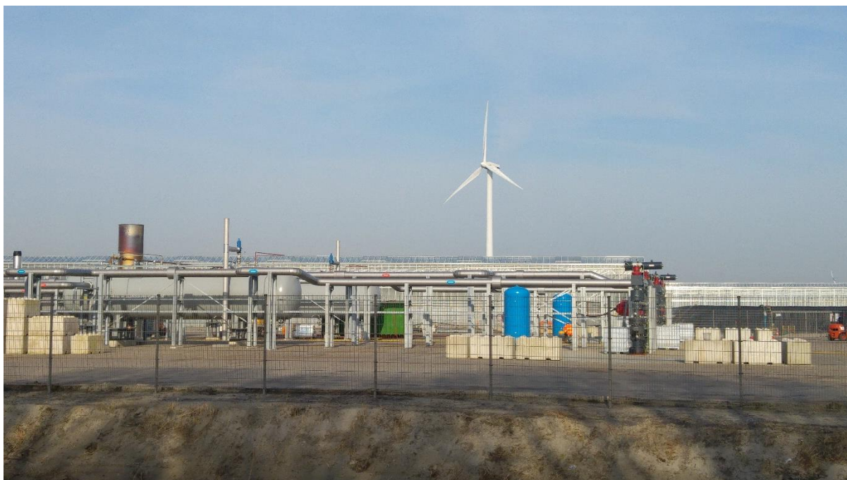
Figuur 6. Foto van het mijnbouwwerk AWI Andijk (buitenterrein)
