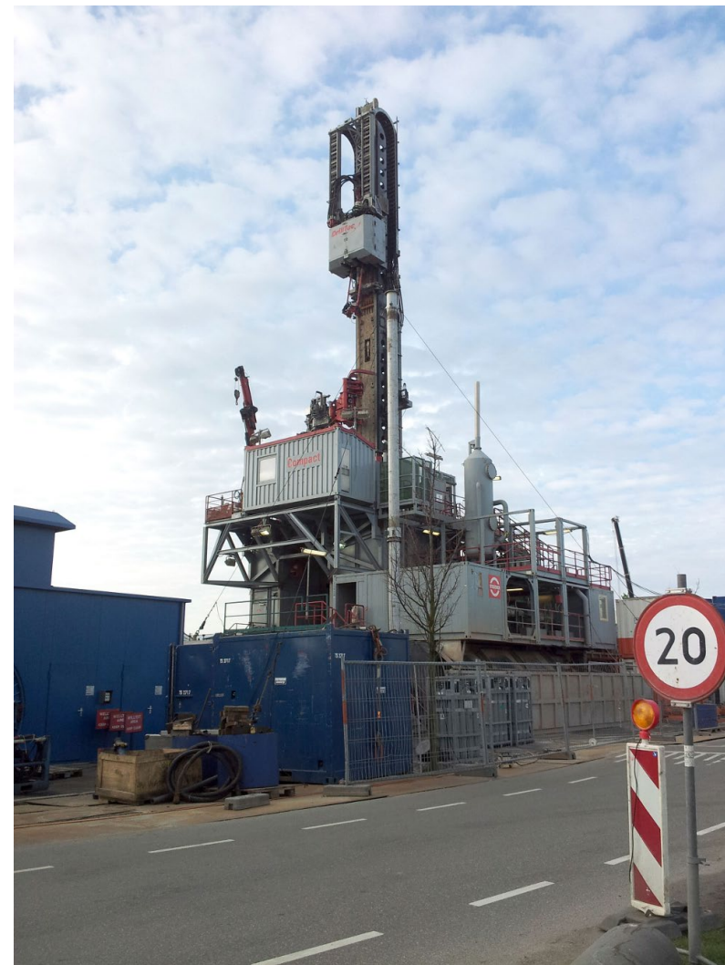
Aardwarmteboring bij Honselersdijk (foto: Geert-Jan Vis)
