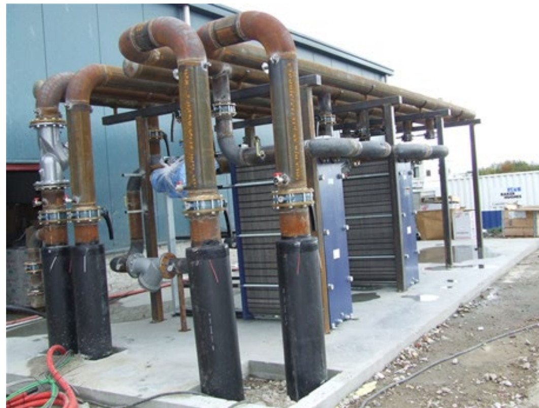
Voorbeeld van een aardwarmtewisselaar (bron: www.energieportal.nl )
