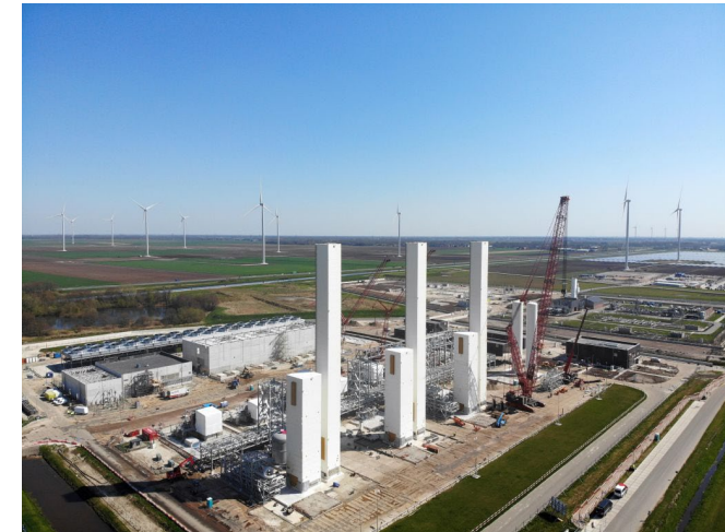
Bouw van de stikstofinstallatie Zuidbroek (bron: https://zuidbroek.gasunie.nl/ )
