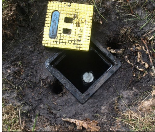
Figuur 7: schroefanker afgewerkt met een peilbuisput
