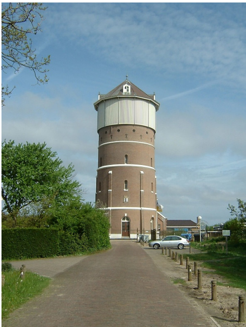
Figuur 1: Aansluitpunt 030D0004
